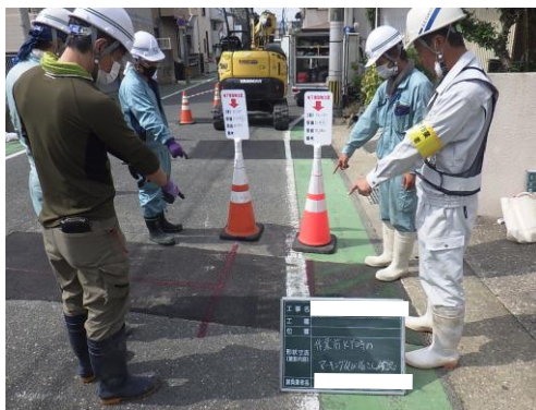
朝礼時の地下埋設物位置情報の掲示と指差し確認
