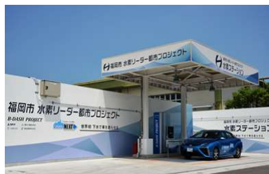
下水バイオガス由来 水素ステーション
